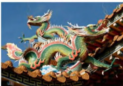
a) Smok na dachu budynku
