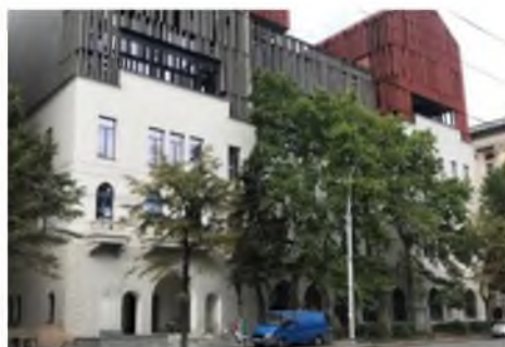
Fot. 9. Nowy budynek z elewacją w dolnej części starego budynku Źródło: (autor)
