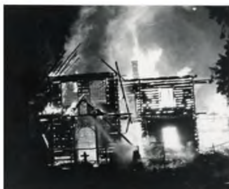
Fot. 18. Pożar pustelni Źródło: (fot. A. Liberak)
