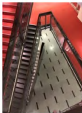
Fot. 6. Drezno, Kulturpalast, klatka schodowa Źródło: (J. Suchanek)
