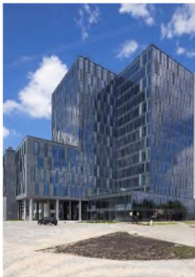
Fot. 7. I etap inwestycji na Helenowie – CZ Office Park Źródło: (K. Szmygin)
