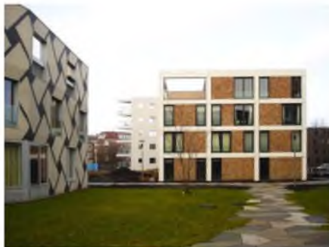
Fot. 6. Widok na ciąg pieszy we wnętrzu dziedzińca zespołu mieszkaniowego Funenpark w Amsterdamie Źródło: (autor)
