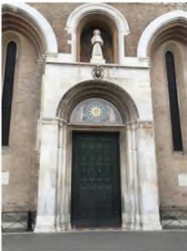
Fot. 8. Główne wejście do bazyliki św. Antoniego w Padwie Źródło: (fot. G. Baldissin Molli)
