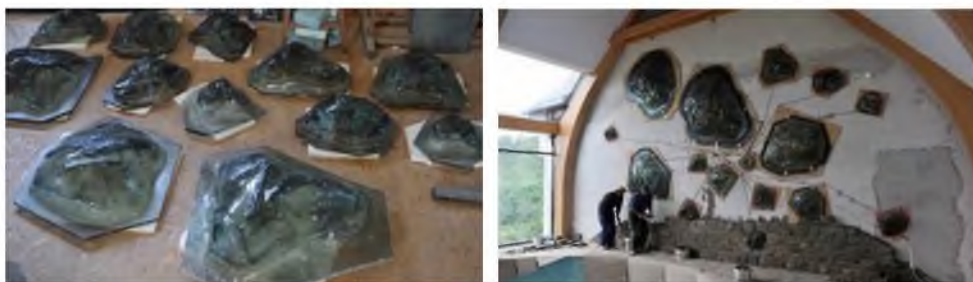
Fot. 14. Proces montażu szkieł, instalacji światłowodowej i obróbki kamiennej na budowie Źródło: (T. Urbanowicz)
