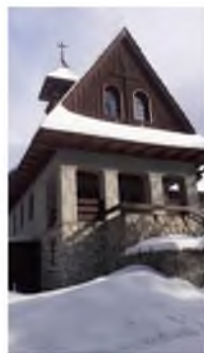
Fot. 20. Widok pustelni braci albertynów od strony północnej po odbudowie Źródło: (fot. b. Hieronim (J. Moroz), 8.04.2021 r.)
