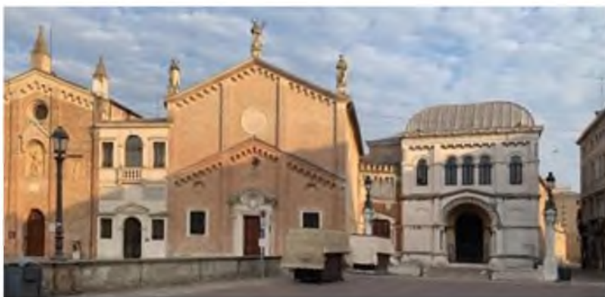
Fot. 5. Piazza del Santo z budynkiem Museo Civico po prawej stronie Źródło: (fot. F. Deutsch)
