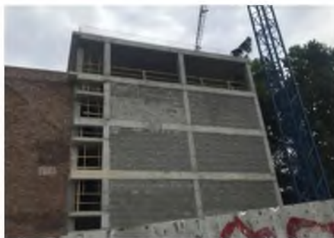
Fot. 5. Połączenie dobudówki i nadbudowy z elewacją Źródło: (autor)
