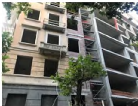
Fot. 3. Proces łączenia frontu z nową częścią Źródło: (autor)
