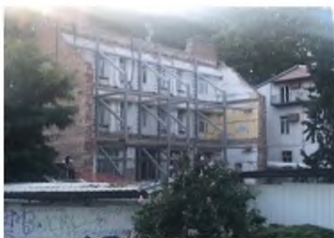
Fot. 4. Wzmocnienie frontowej ściany hotelu „Muza” Źródło: (autor)
