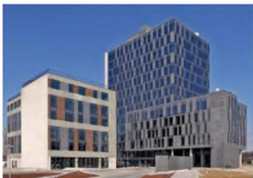
Fot. 8. I etap inwestycji na Helenowie – CZ Office Park Źródło: (K. Szmygin)
