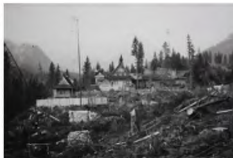
Fot. 14. Prace przy naprawie zniszczeń wokół pustelni po huraganie w 1968 r. Źródło: (ASA)
