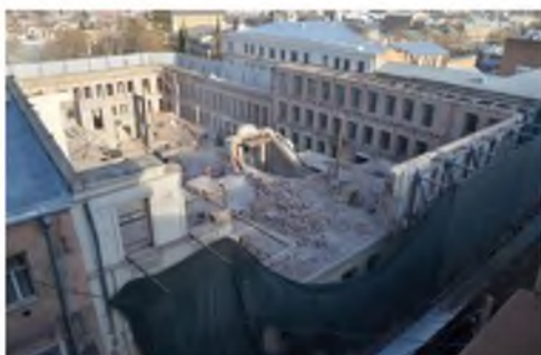
Fot. 6. Wzmocnienie ścian elewacyjnych i rozpoczęcie prac Źródło: (zdjęcie Fund.ge)
