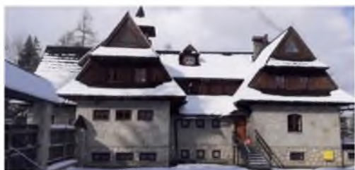
Fot. 24. Widok od strony dziedzińca po odbudowie Źródło: (fot. b. Hieronim (J. Moroz), 8.04.2021 r.)
